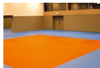
Überblick: Fertiggestellter Judoboden inkl. Matten
