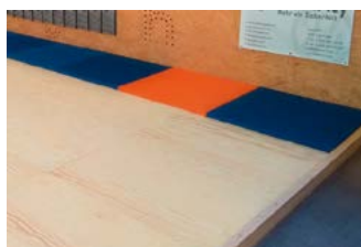
Unterkonstruktion mit Tatamis
